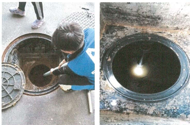
รูปภาพที่ 2.40 การตัดไขมันจากบ่อไขมัน
