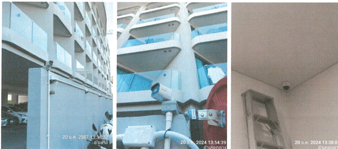
รูปภาพที่ 2.26 ระบบโทรทัศน์วงจรปิด
