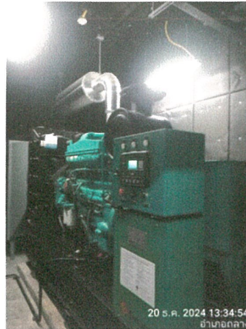
รูปภาพที่ 2.18 เครื่องกำเนิดไฟฟ้าสำรอง
