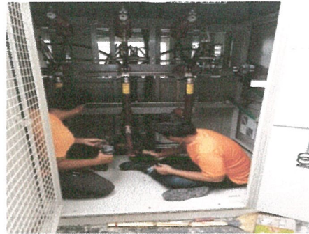
รูปภาพที่ 2.47 การตรวจสอบหม้อแปลงไฟฟ้า
