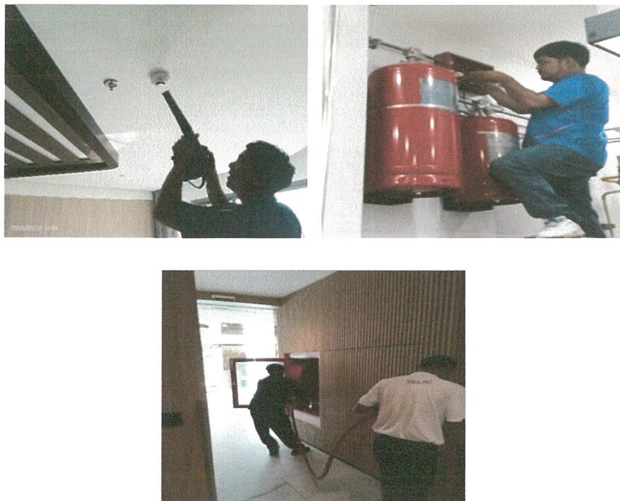
รูปภาพที่ 2.50 การตรวจสอบระบบป้องกันอัคคีภัย
