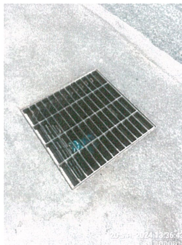
รูปภาพที่ 2.12 ตะแกรงดักมูลฝอย
