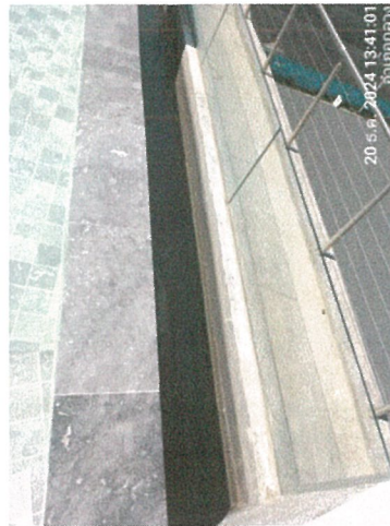
รูปภาพที่ 2.34 รางระบายน้ำล้นรอบสระว่ายน้ำ
